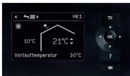
Display på värmepumpreglering Vitotronic 200
